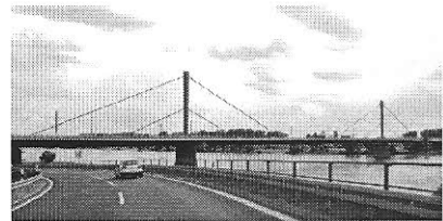
L Leverkusener Autobahnbrücke
