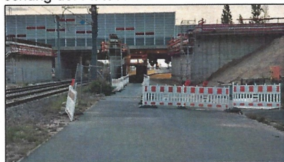
Bild 6 Etwa im Bereich der Baken wird der neue Überweg über die Gleise zur Endhaltestelle entstehen Foto: M.Schmidt
