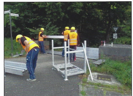
Bild 7 Aufbauübung von mobilen Hochwasserschutzelementen im Fuhlig (Foto: Klais)
